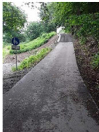
Die ausgebrochenen Asphaltstücke wurden durch den Bauhof der Stadt Adorf erneuert und anschließend neu asphaltiert.
