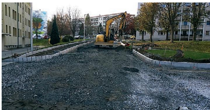
den Untergrund für den Asphalt-einbau vor. Für die 45. bzw. 46. Kalenderwoche ist der Einbau der Asphalttragschicht vom Parkplatz Schillerstraße 23 bis zur Verbindung Schillerstraße Nr. 10 bis 24 geplant. Die Straßenbeleuchtung wurde in diesem Teil bereits in Betrieb
