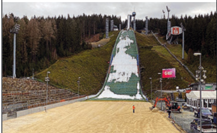
Der Schanzenauslauf der Klingenthaler Vogtland-Arena wird derzeit durch Mitarbeiter der VSTR Rodewisch AG zum Eisstadion umgebaut. 400 Tonnen Sand bilden die Grundlage für die Eisfläche. Foto: Thorald Meisel
